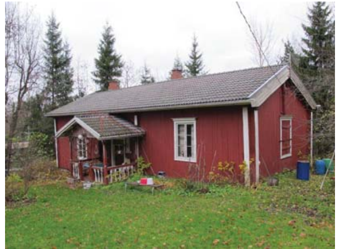
Etupuoli kohti pihaa (etelä) ja itäpäätä. Rakennuksen itäpäädyssä luukkuikkuna.
