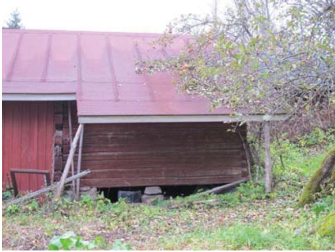
Taloustrakennuksen tielle päin oleva länsipääty ja osa eteläseinästä on pystylaudoitettu ja peiterimoitettu. Koko pohjoissivu, itäpääty ja osa eteläsivusta on paljasta hirsiseinää.
