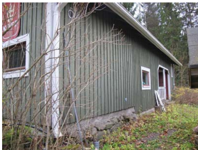
Talusrakennuksen länsisivu kohti pihaa.
