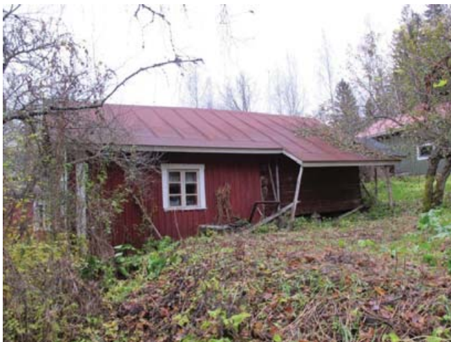
Pihan keskellä olevan talousrakennuksen eteläisivu.
