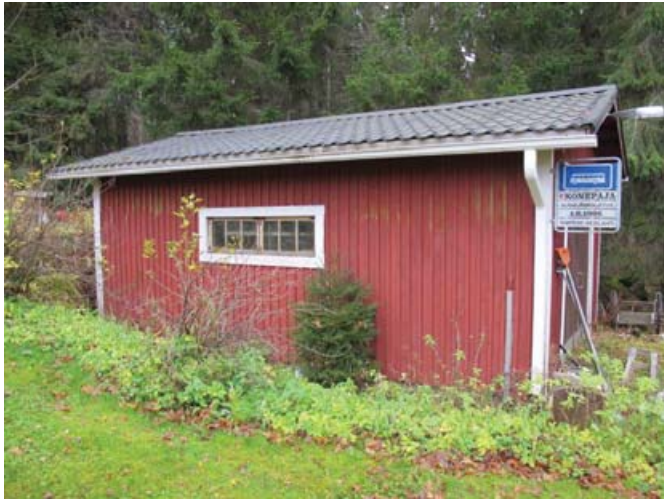
Rakennuksen pohjoissivu kohti pihaa.
