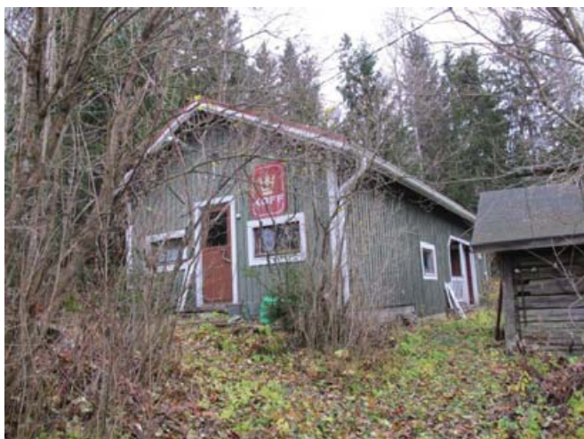
Talusrakennuksen pohjoispääty. Oikealla aitan (rakennus 003) kulma.
