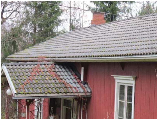
Rakennuksen ja kuistin katto.
