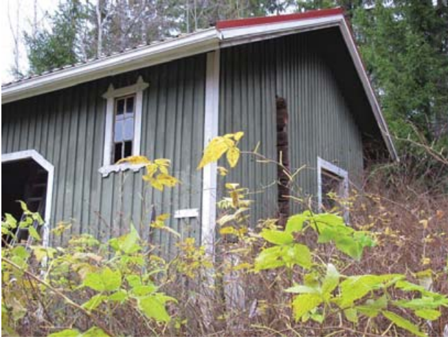
Rakennuksen eteläpäädyssä näkyvät vanhan aittarakennuksen nurkkahirret.
