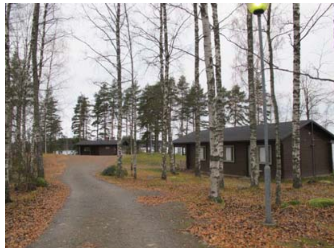
Lammasniemen kärjen virkistysalueen rakennuksia.
